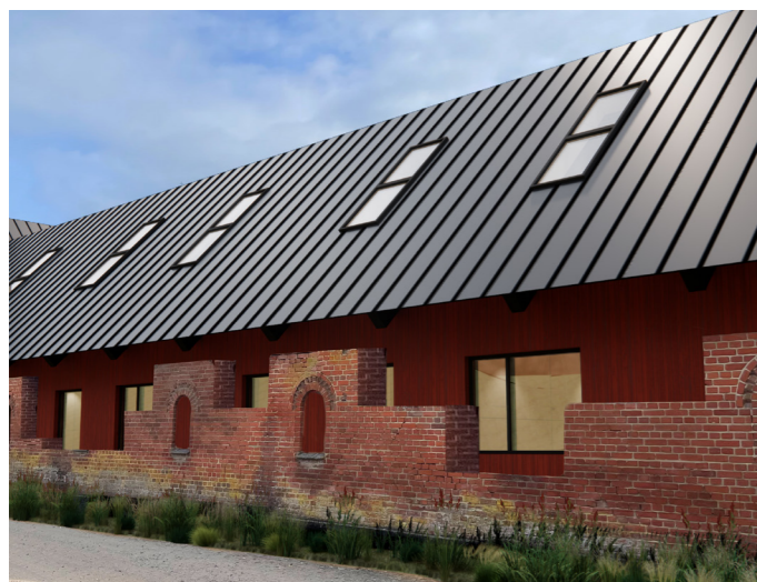
Den eksisterende bygning rives delvist ned og gør plads til en ny indsats, der bruger den eksisterende sokkel og bevarer dele af den eksisterende mur.
