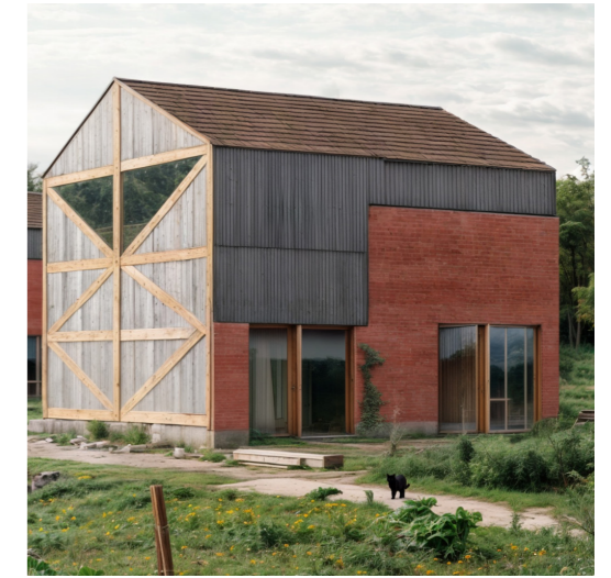
Neobindingsværk. Robust træramme er et fleksibelt skelet, hvor genbrugsmaterialer kan indkorporeres. Det muliggør brugen af varierende teknikker og materialer, samtidig med at der opretholdes en modular logik, så husene løbende kan ombygges. Peter Allan Klode Gustafson, Asferg skovbjerg Leick
