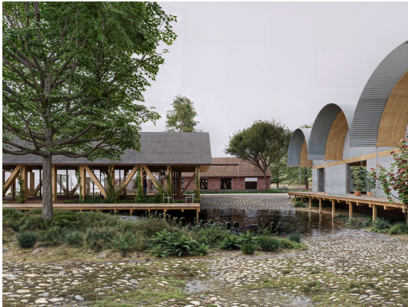
Naturbørnehuset, eksempel på at omdanne det urbane landskab med nyt byggeri i genanvendte og tilgængelige materialer. Byggeri bygget på pælefundament, hævet over det våde terræn.
