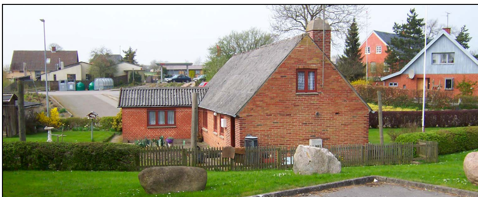
En beboelsesbygning på Kastanievej 9 fra år 1900 som nedrives i forbindelse med projektet. Tilsvarende bygninger på Kastanievej 11 og 13 er allerede nedrevet i december 2004.
