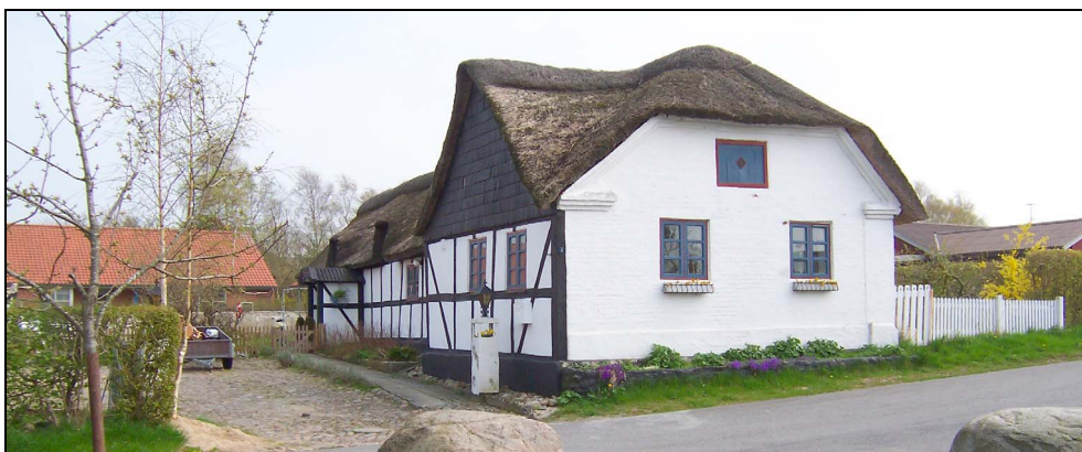
En beboelsesbygning på Vangvejen 3 fra år 1800, som nedrives i forbindelse med projektet.
