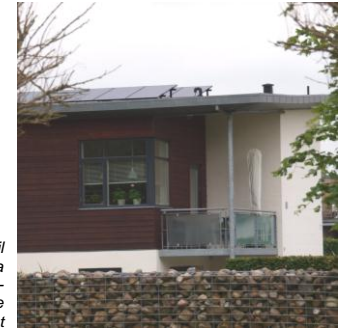
Panelerne er vinklet 15 grader i forhold til vandret plan. Afstandskravet på 150 cm fra tagkanten er overholdt. Panelernes tilstedeværelse på taget er diskret og svækker ikke helhedsindtrykket
