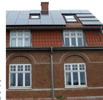
Solcellerne er monteret på tagfladen som applikeret anlæg i uregelmæssige felter uden hensyn til husets arkitektoniske udtryk, hvorfor ejendommen skæmmes
