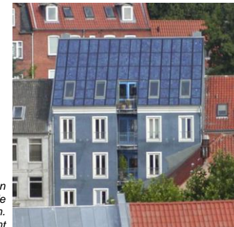
Nyt byhus med et integreret solcelleanlæg i den sydvendte tagflade. Panelernes udstrækning på hele tagfladen samt afslutningerne ved tagkanter m.m. som et arkitektonisk element
