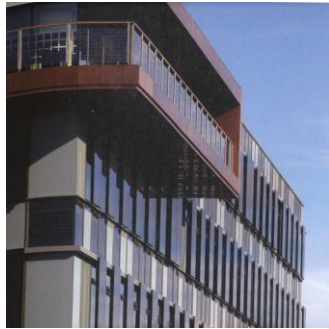
Solceller i facaden er med til at forstærke og fremhæve vinduesbåndene
