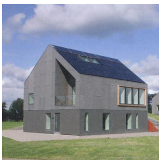
Moderne villa med tagflade udformet som integreret solcelleanlæg
