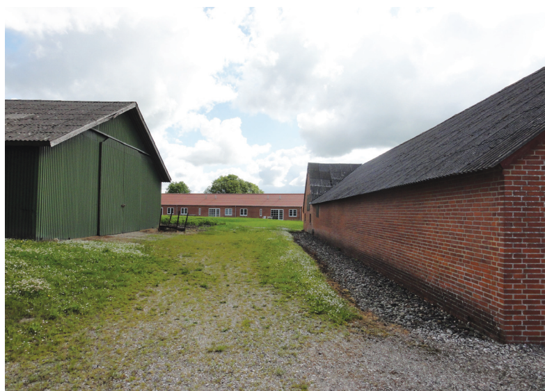
Et kig mellem driftsbygningerne til Bjerregravvej 4 over på de noget fremmedartede rækkehuse, hvor der tidligere lå en firlænget gård.
