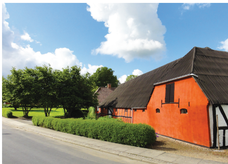
Tånum Bygade 8 er en af de rigtig gamle gårde i Tånum, der vedligeholdes løbende. Gården er en vigtig del af gårdmiljøet i den sydøstlige del af Tånum, omkring Tånum Bygade.
