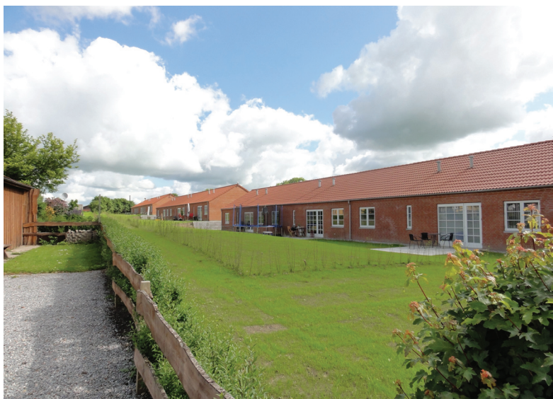
Tidligere lå der en gammel firlænget gård på Gl. Viborgvej 212. Gården var i meget dårlig stand og i stedet for en restaurering, blev den revet ned og erstattet af disse tre rækkehuse med i alt ni boliger.
